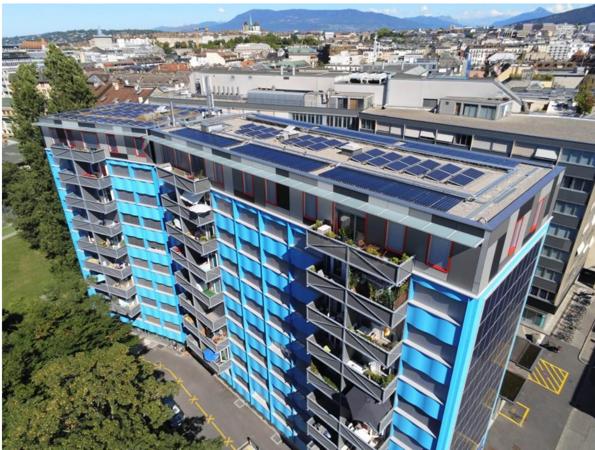
Figure 10: Le bâtiment collectif de la coopérative après rénovation. Source : Dasta, http://www.dasta.ch/references/cooperative-la-ruche-rue-des-maraichers .
