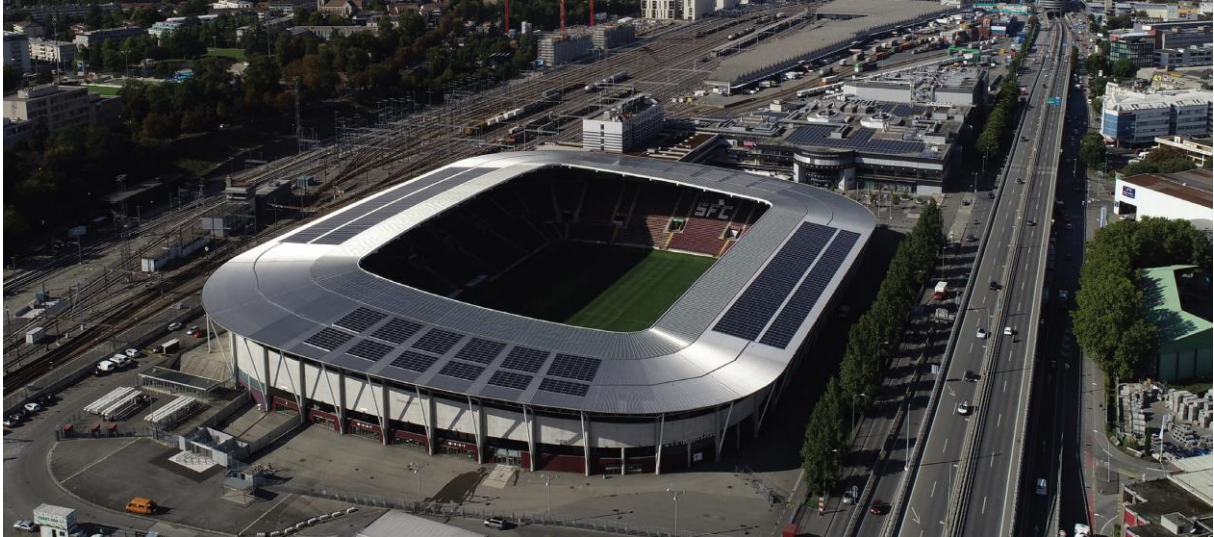
Figure 8: Centrale photovoltaïque du Stade de Genève. Source : Solar Agentur, https://www.solaragentur.ch/fr/prix-solaire/prix-solaire-suisse/2021/stade-de-geneve-solaire-1212-grand-lancyge .
