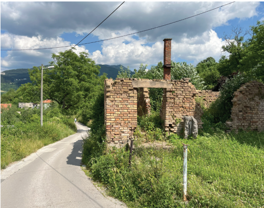
Exemple de ruine rencontrée dans la périphérie sud
