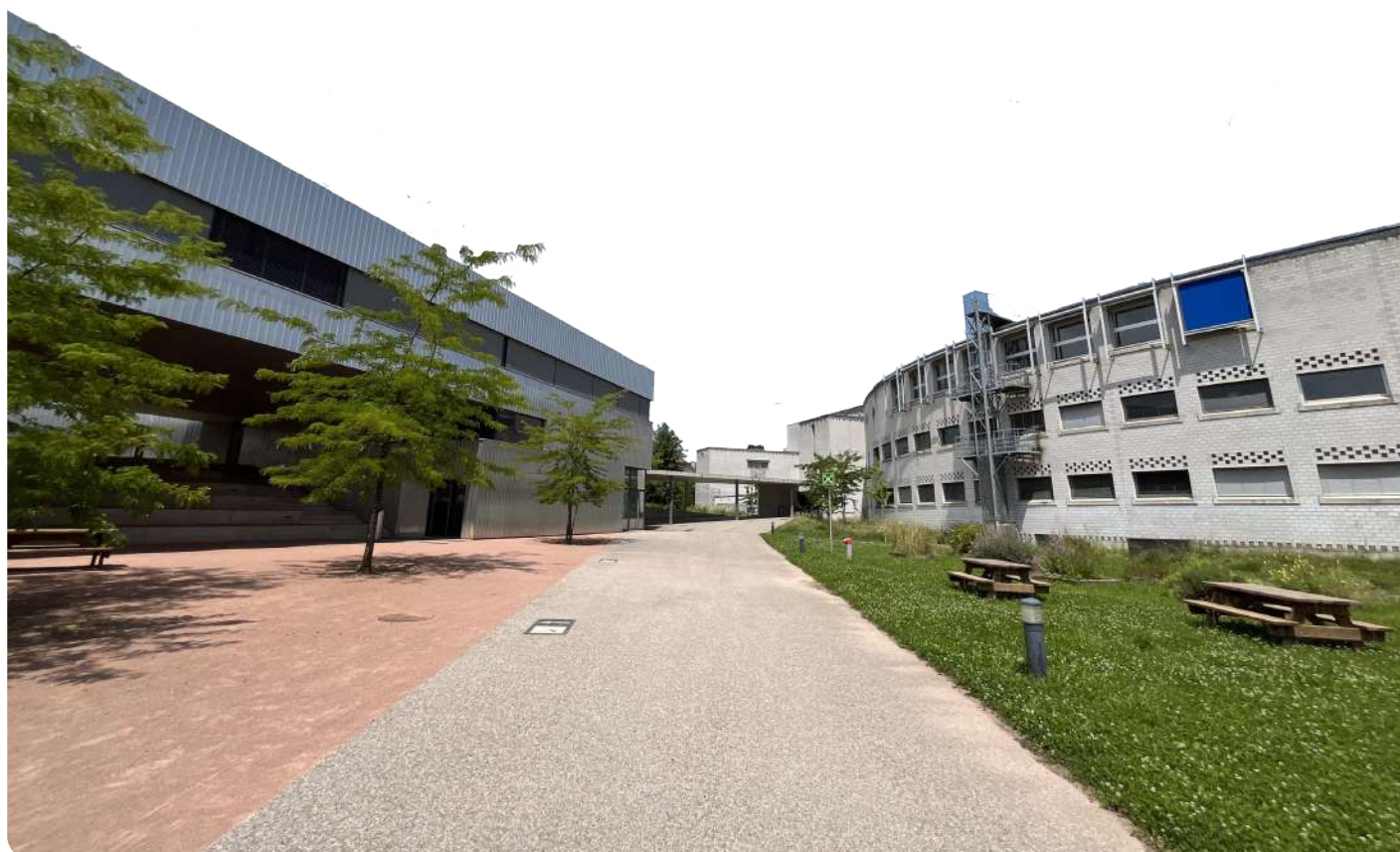
fig. 18: préau gymnase de Nyon. photo prise par nos soins ©
