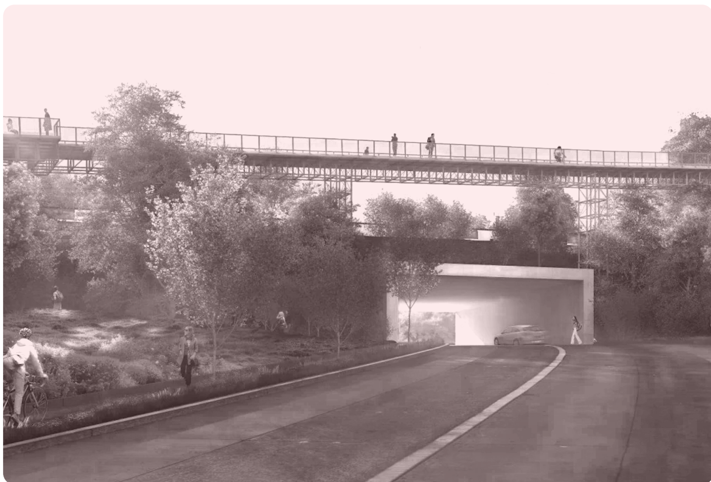
fig. 7: passerelles de mobilité douce: Nyon-Prangins et Bois-Bougy. photo: Explorations Architecture
