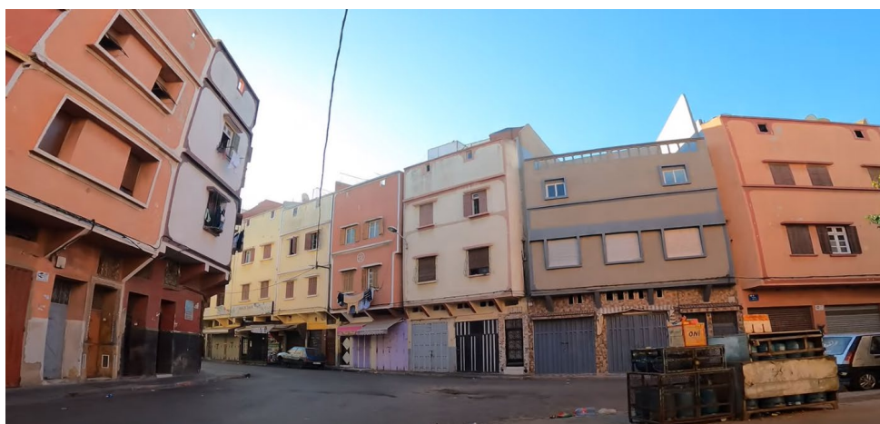
Figure 10: Maisons marocaines modernes, quartier Ben M'sick, Casablanca, 2025
