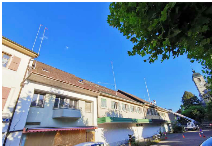
FIGURE 2 – Exemple de garabits en toiture 2 .
