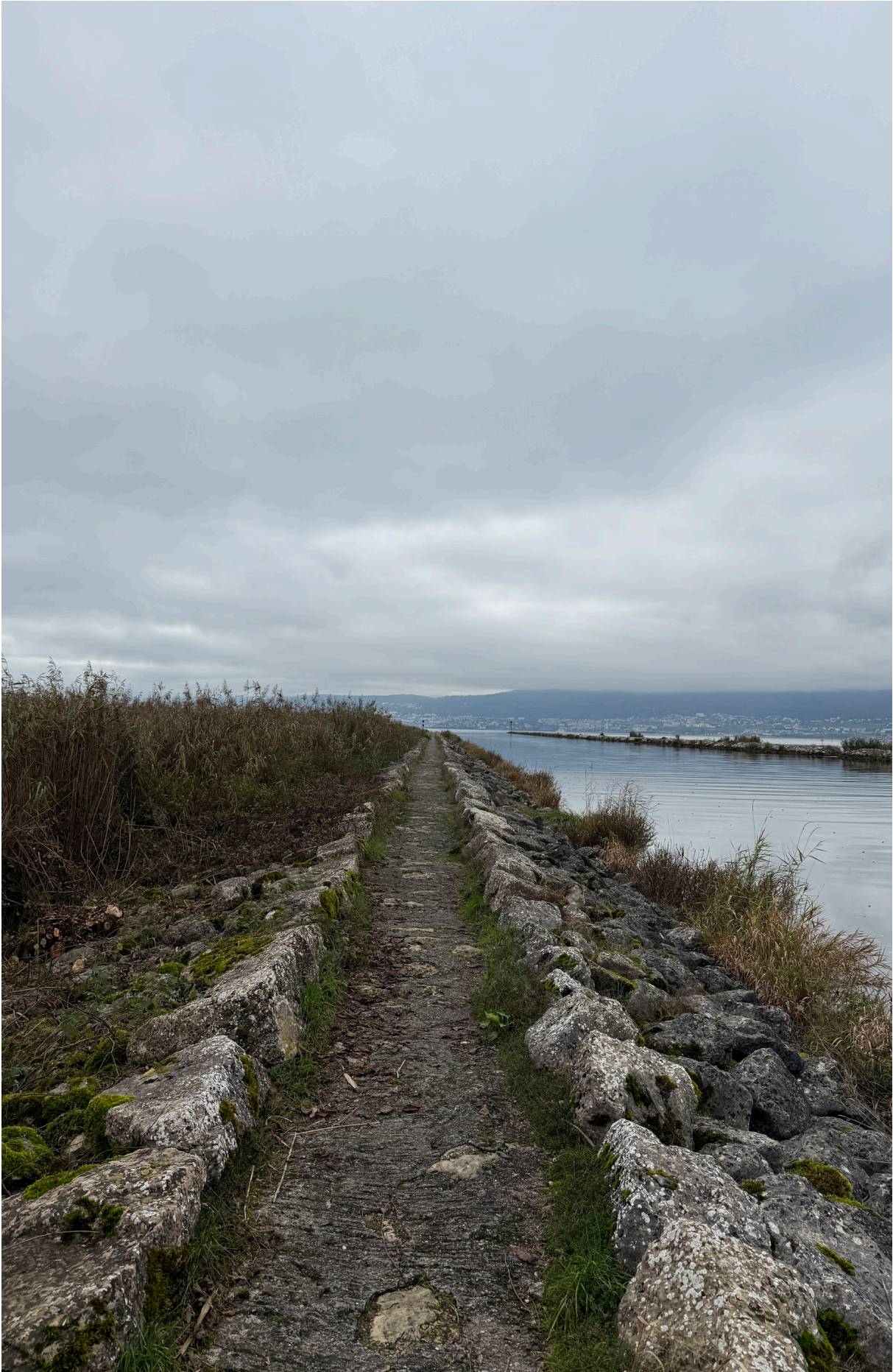
fig. 7 canal de la Broye, Cudrefin
