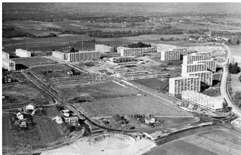
Figure 28 : Construction de la cité-satellite en campagne. Source : new.espazium.ch
