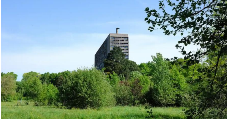
Figure 4 : parc de la "maison radieuse" réalisé par Le Corbusier en 1955, près de Nantes. Source : maisonradieuse.org, 2022
