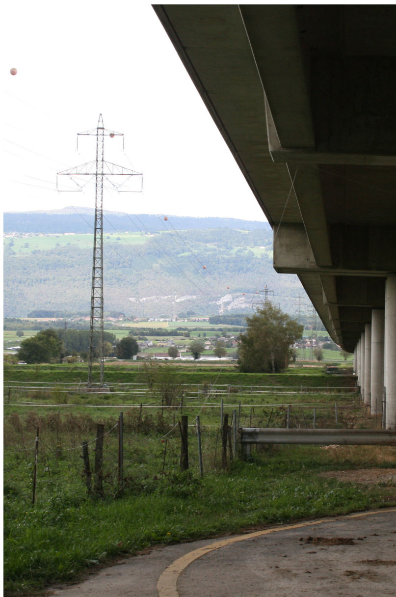
Paysage de la frange périurbaine à Yverdon-les-Bains (photographie Rémi Douce)
