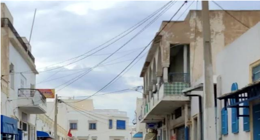
Certaines façades de maisons sont laissées à l'abandon.
