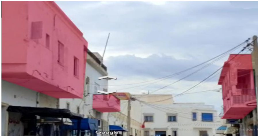
Des balcons en béton dépassant largement sur la rue
