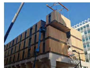
Construction d'un bâtiment à base de conteneurs à Monaco
